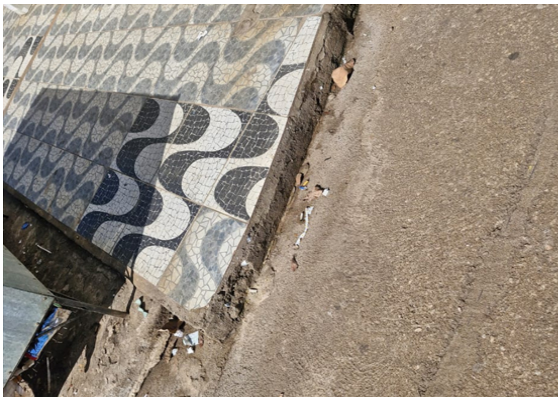
Fotografia 02: Desnível logo após a passagem pela rampa de acessibilidade a faixa
