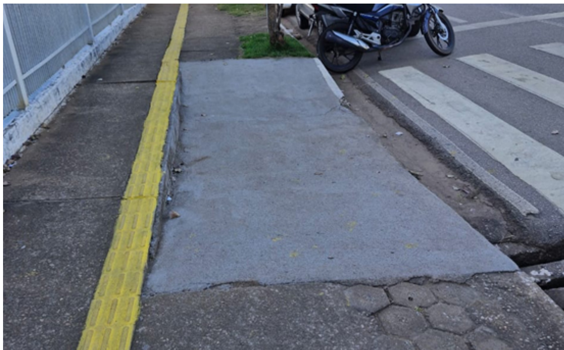
Fotografia 01: Rampa de acessibilidade e calçadas para deficientes com desnível
